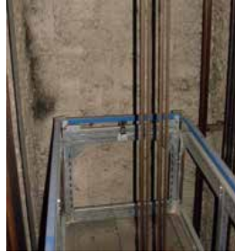
Amiante friable sur les murs de gaine – risque de maladie si exposé à la poussière ou si retiré sans aucune précaution
