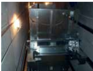
Θάλαμος αναρτημένος από τα συρματόσχοινα και ο περιοριστής ταχύτητας σε λειτουργία.
