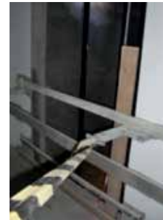
Αποτελεσματική μπάρα τοποθετημένη μπροστά από το φρεάτιο, για να αποτρέψει τους εργάτες του εργοταξίου και τους υπαλλήλους να πέσουν στο φρεάτιο.
